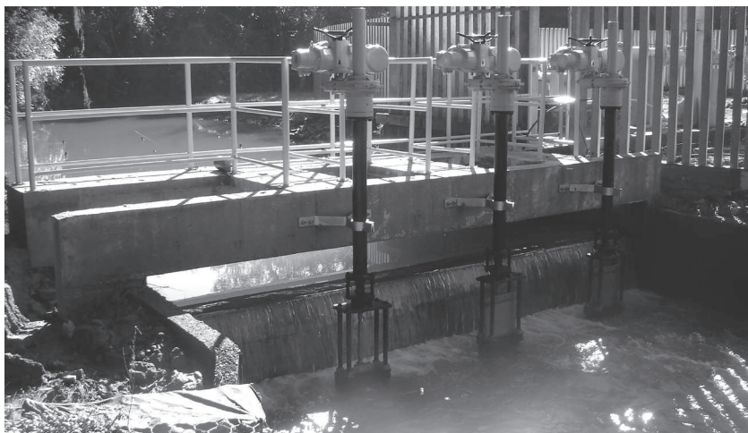
Figura 6.8 – Barragem de nível a jusante do Ponto de Captação da ETA Cercadinho
