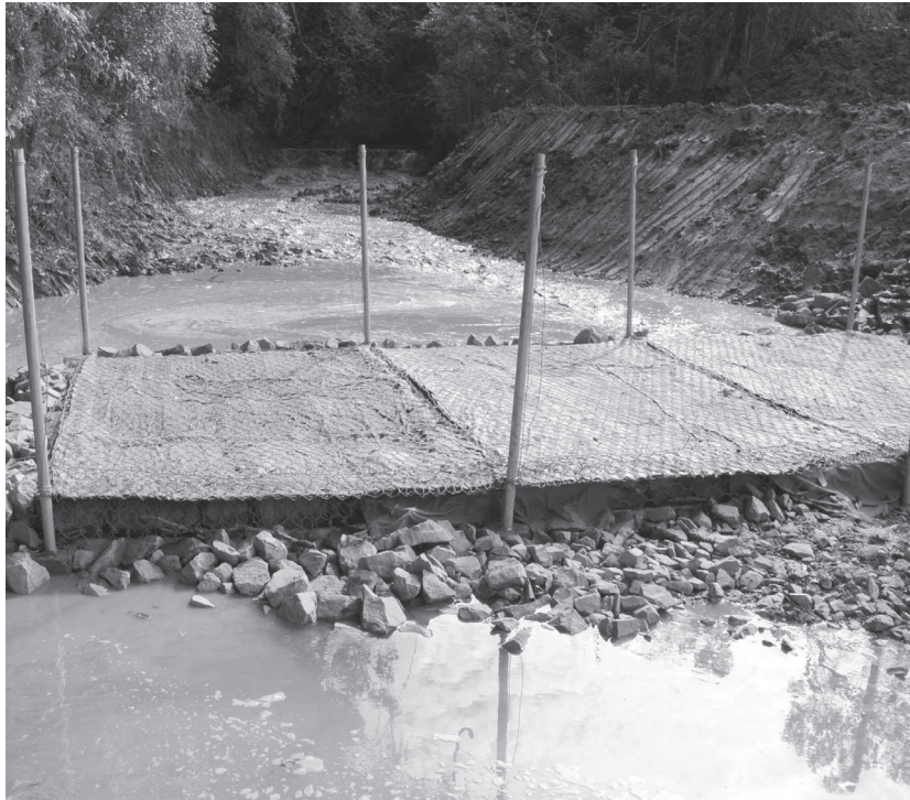
Figura 6.5 – Fase final do filtro recoberto por manta
