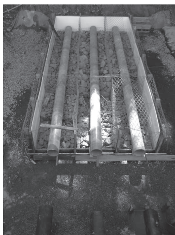
Figura 6.3 – Fase intermediária de montagem do filtro
